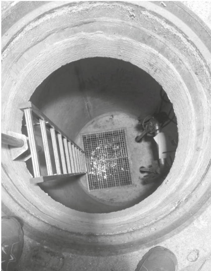
In der Pumpstation Glashütte wurde ein Doppelwellenzerkleinerer in 6 m Tiefe eingebaut.
