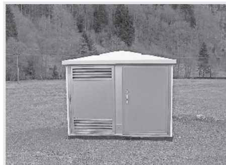
... und an neuer Stelle bei der Umgehungsstraße wieder aufgebaut.
