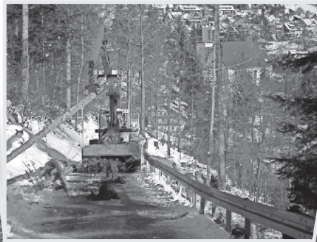
Neue Leitplanken wurden zur Verkehrssicherung in Glashütte und bei den Wasserfällen angebracht.
