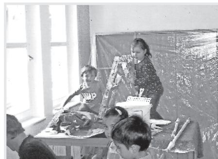
Im Kindergarten wurden dringend notwendige Malerarbeiten unter Aufsicht der Kindergartenkinder ausgeführt.
