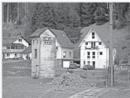
Im März wurde das alte Trafohäuschen in Todtmoos-Höfle abgerissen...
