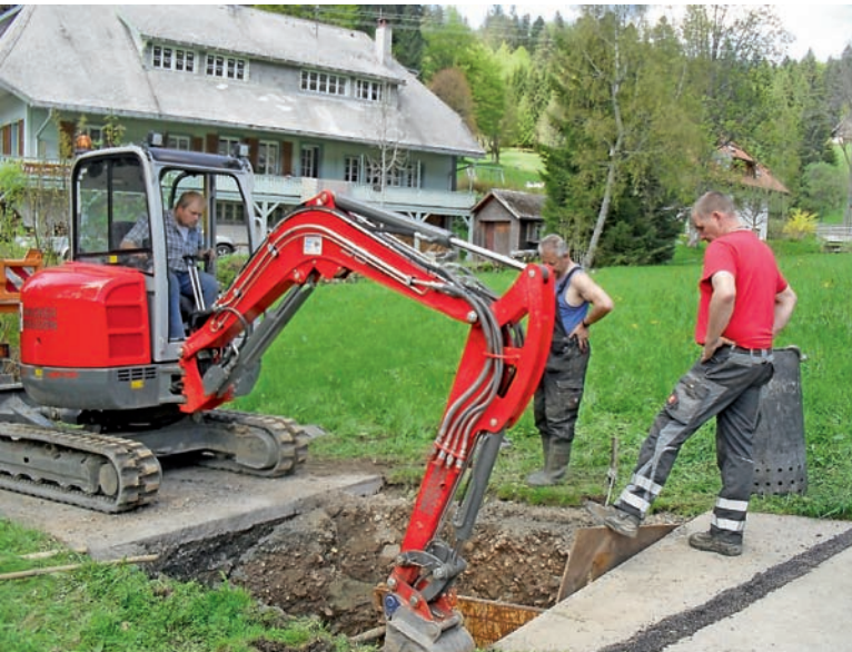
Erneuerung Trinkwasser-Schieberkreuze in Rütte
