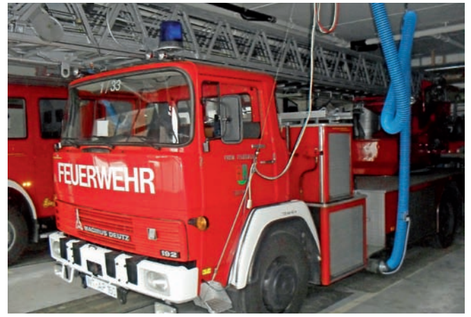
Absauganlage für die Feuerwehrfahrzeuge
