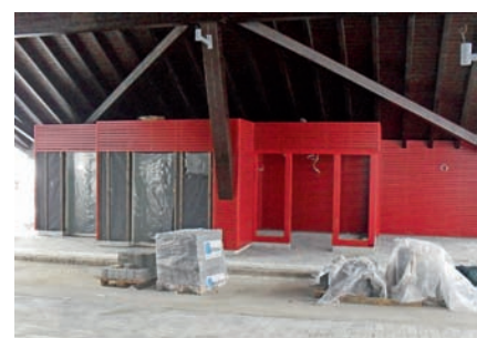
Neue barrierefreie WC-Anlage im Busbahnhof
