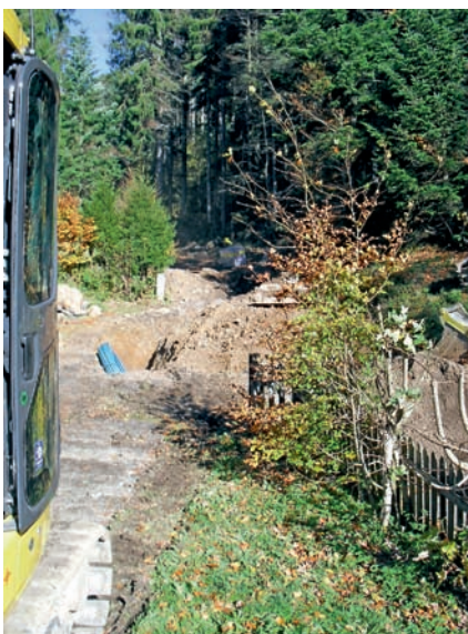
Bauarbeiten zur Wasserversorgung des „Fichtenhofs“
