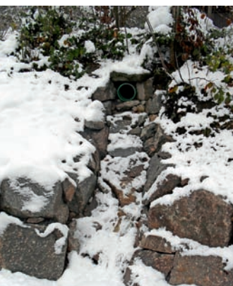
Wasserläufe Herrenkopf- und Kurparkweg
