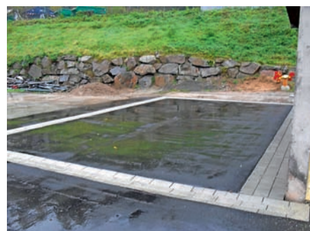
Neuer Kfz-Waschplatz im Bauhof
