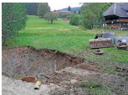
Kanalsanierungsarbeiten in Strick
