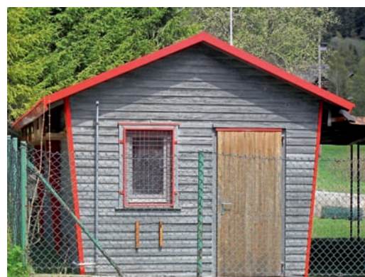
Brutanlage des Angelsportvereins in Rütte
